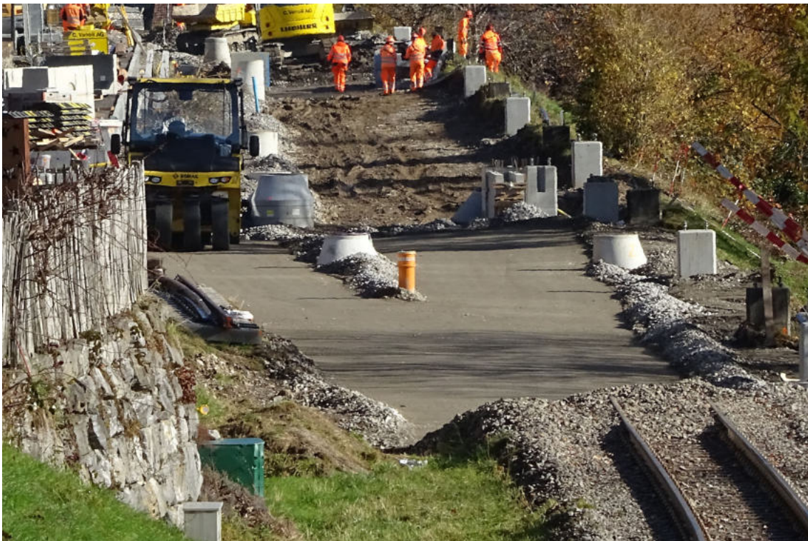
Diese Planie wurde geglättet.
