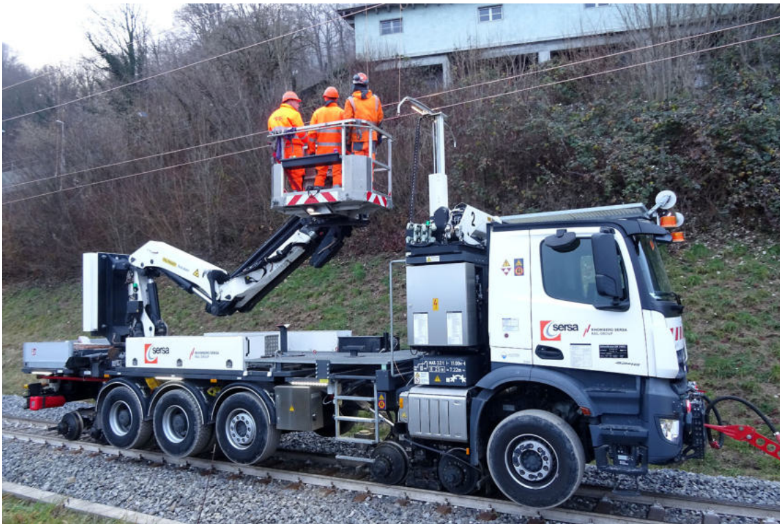
Letzte Justierungen an den Fahrleitungen.
