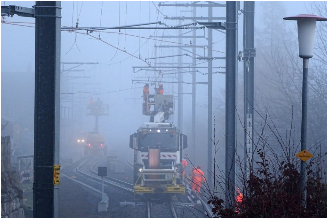
Die Fahrleitungen wurden montiert.
