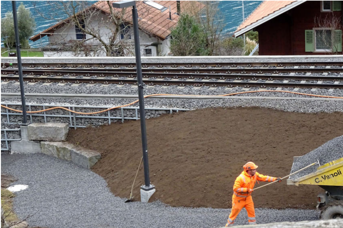
Im Frühling wurde angesät!
