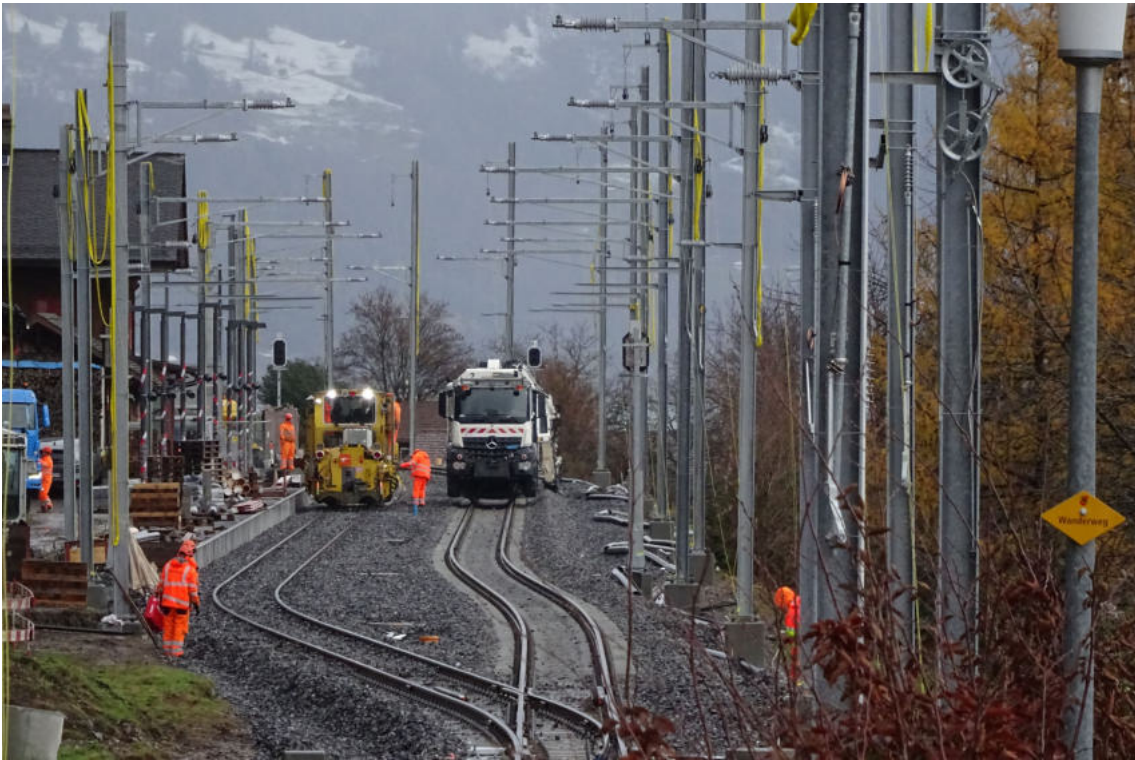
Kaum standen die Masten und noch während die Stopfmaschine ihre Arbeit am Gleis 1 beendete machten sich die Leitungsbauer an die Arbeit.
