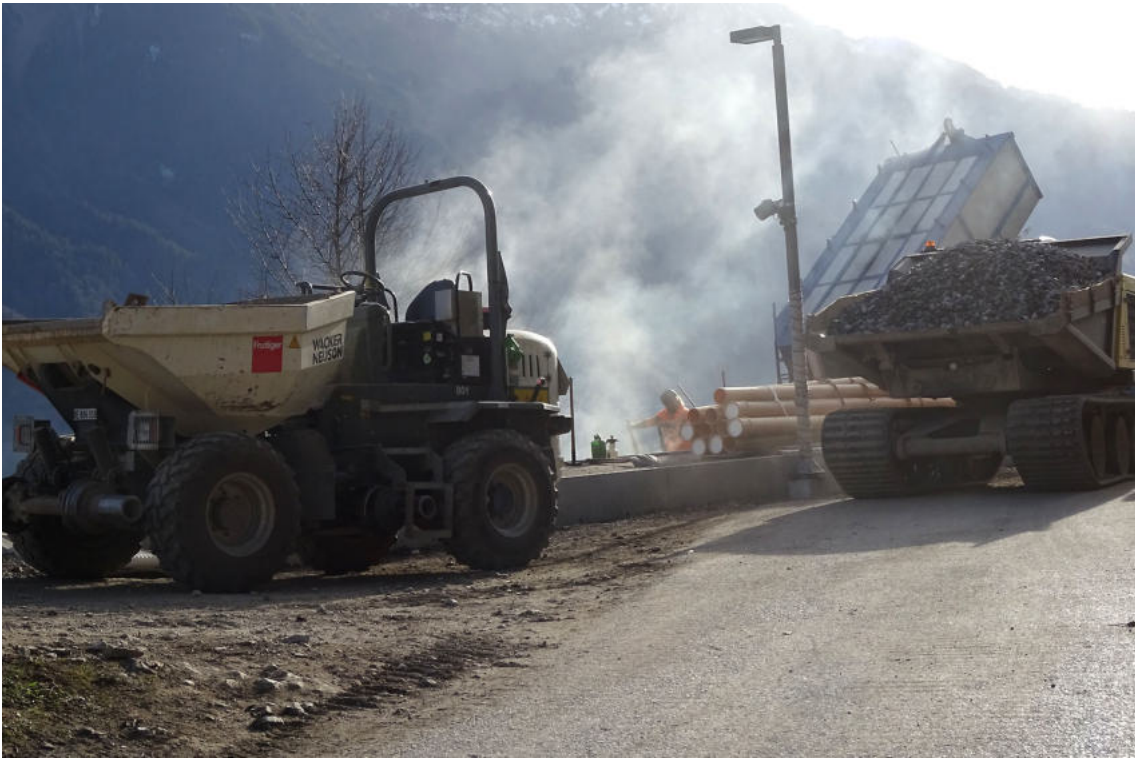
Der Motor der Raupe 'tönt'! Ansonsten verlief der Bau vergleichsweise leise.
