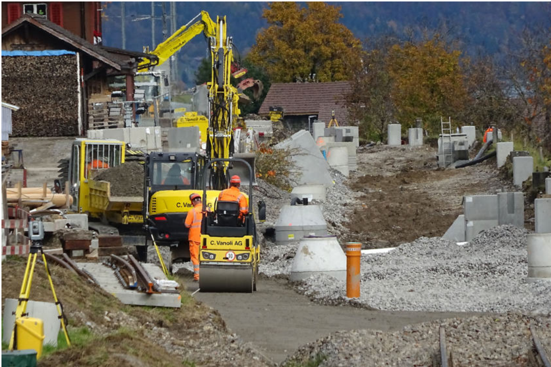
Für das Gleisbett wurde Schotter und darauf Planie eingebracht.
