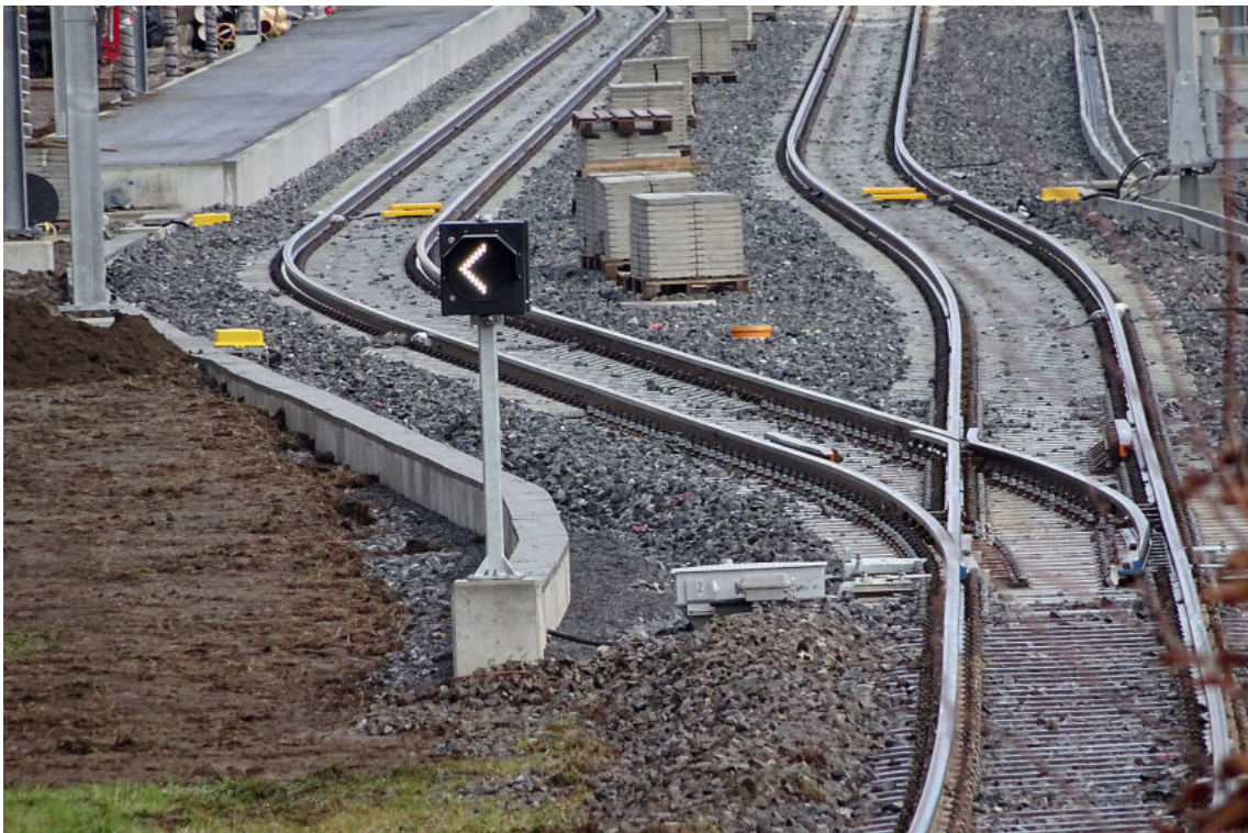
Ob das neue Weichensignal wirklich zeigt wie es soll? Die Abdeckungen vom Leitungskanal liegen bereit.
