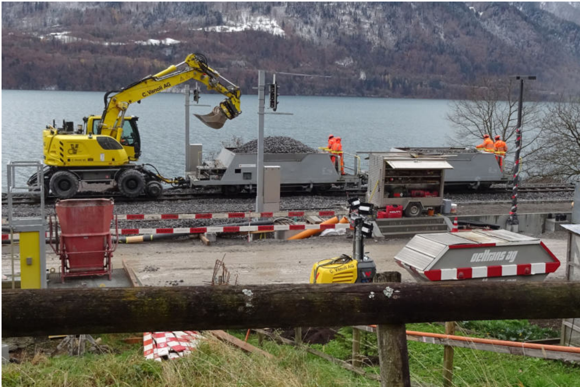
Der Schotter wurde in der Fahrt eingebracht ...
