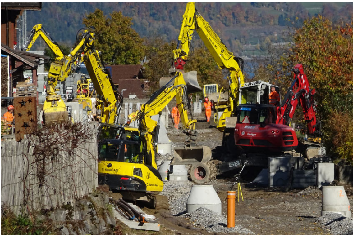
'Baggerballett': Einerseits wurde noch abgebaut, andererseits neu erstellt.
