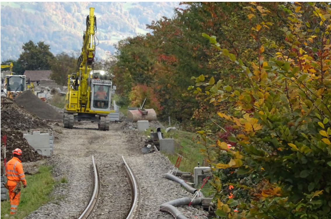
Es erfolgte der Aushub, das Entfernen der alten Trasse. Gleich zu Beginn wurden die neuen Mastfundamente gegossen.
