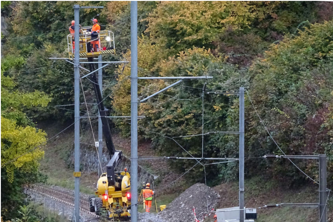
Die Fahr-, Erd- und Speiseleitungen wurden abgebaut.
