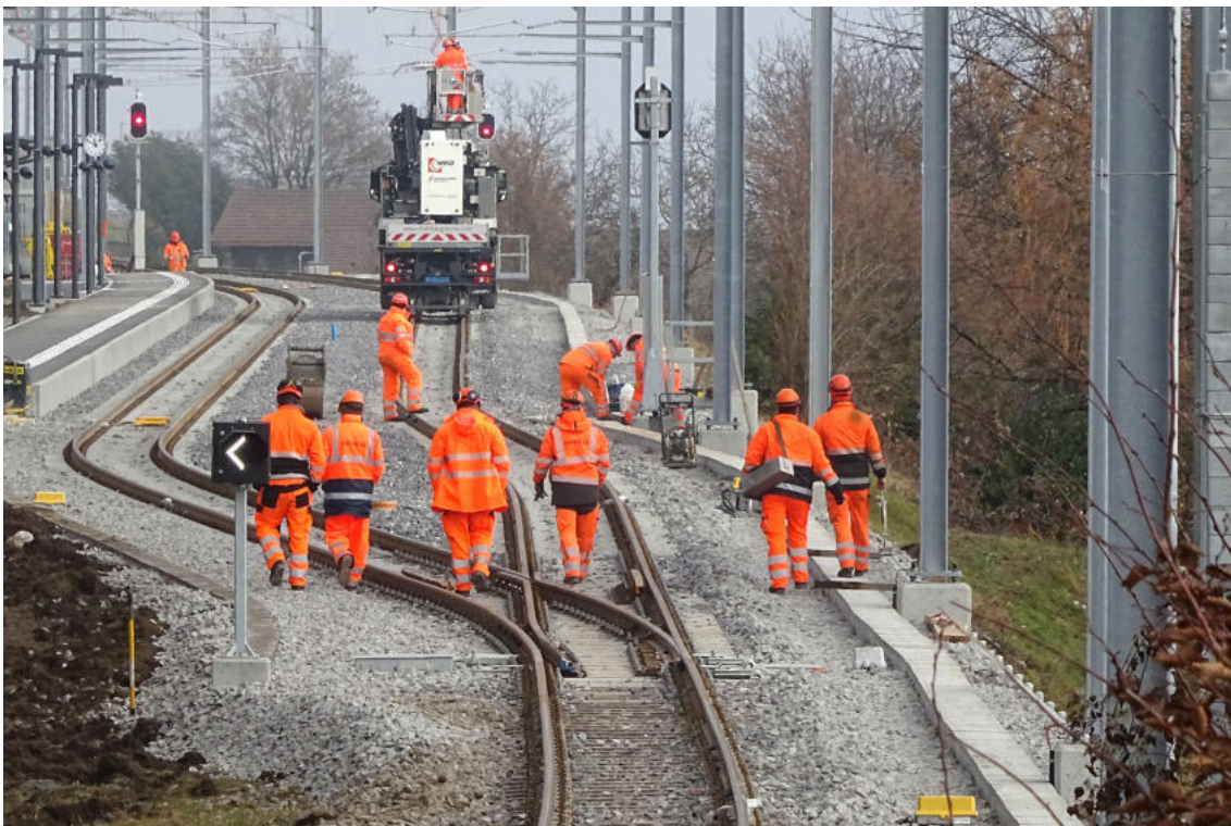
Die Weichenprüfung ist erfolgt. Und siehe da: Nun stimmt die Richtung!
