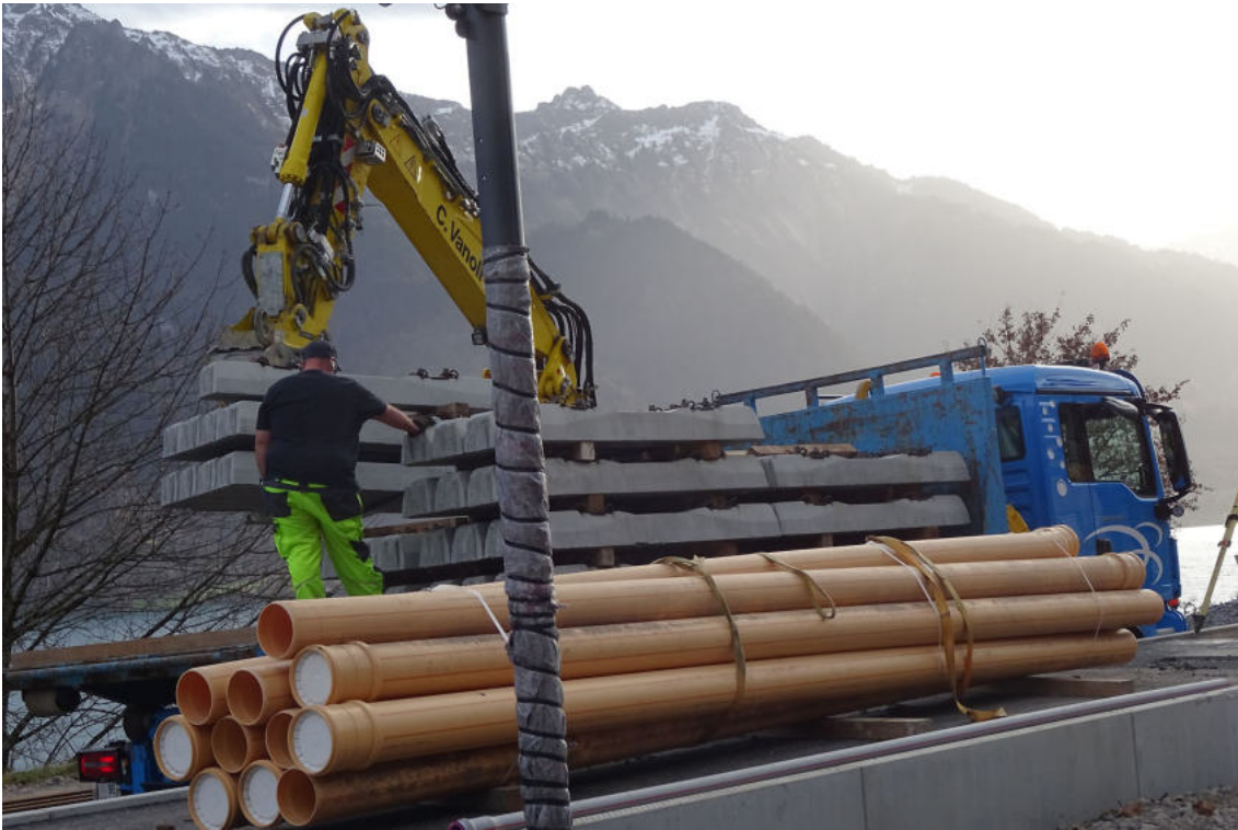
Die Schwellen wurden bereitgelegt...
