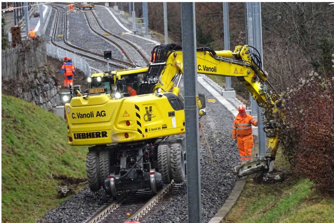
Die Träger für Holzmasten, letzte Zeichen der Elektrifizierung von 1942, wurden entfernt.
