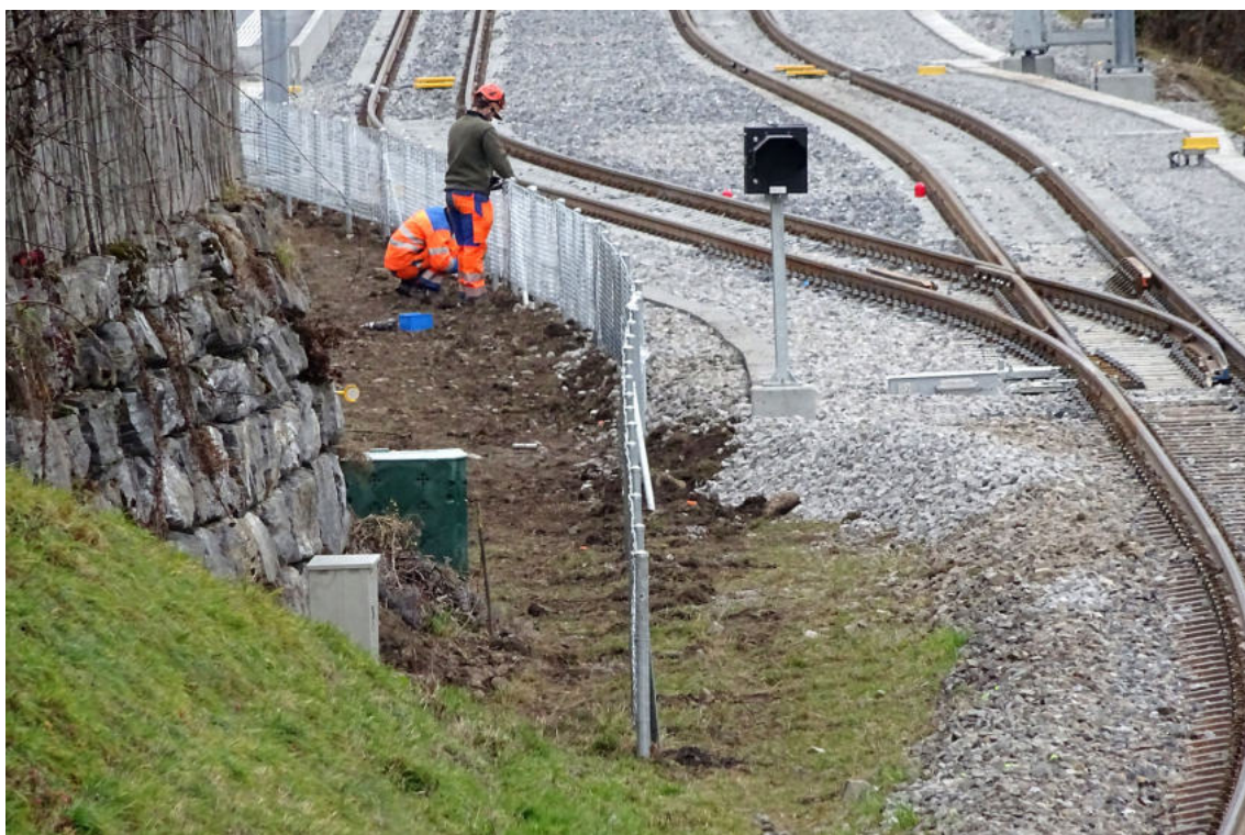
Der Schutzzaun wurde fixiert.
